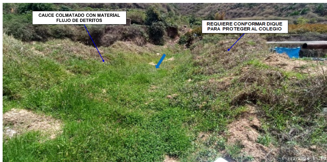
FIGURA N°02: CAUCE COLMATADO CON MATERIAL DE FLUJO DE DETRITOS, PONIENDO EN RIESGO A DESBORDES HACIA AMBOS LADOS QUE AFECTARÍA AREAS DE CULTIVO, VIVIENDA Y EL COLEGIO REUBICADO ANTES MENCIONADO.
